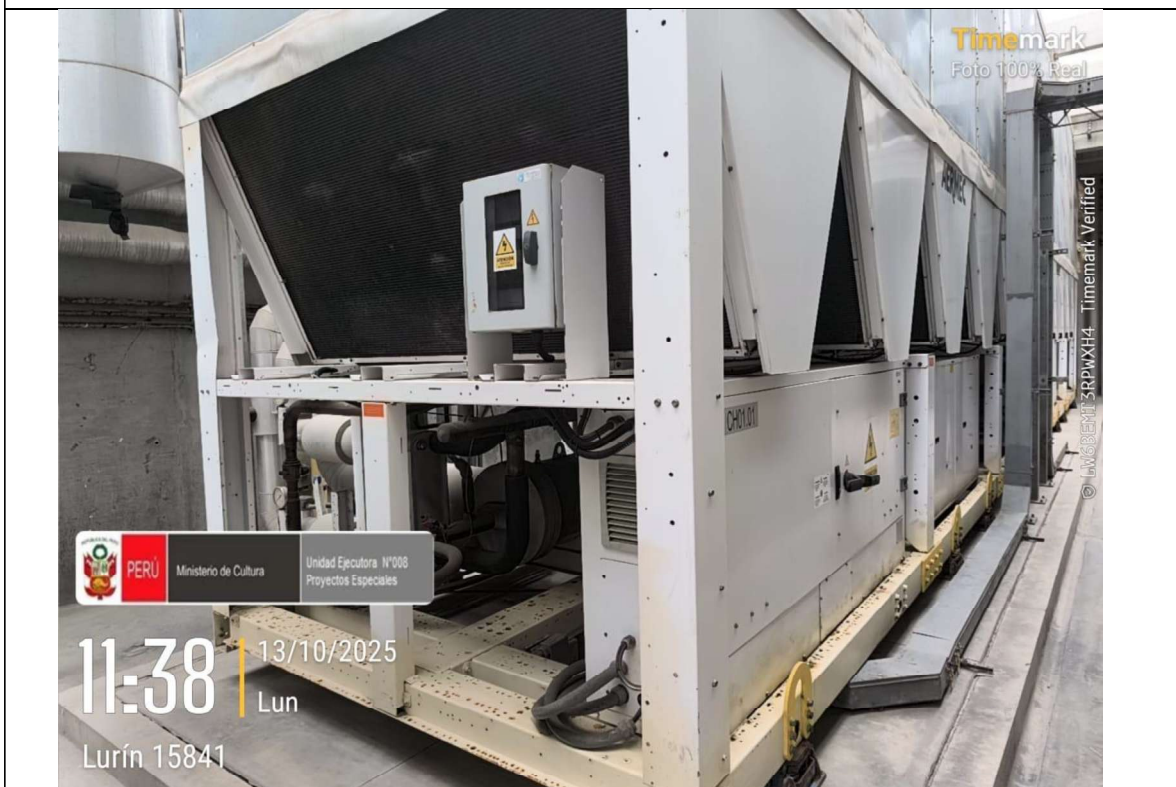
Imagen N° 02: Equipo Chiller's CH01.01
